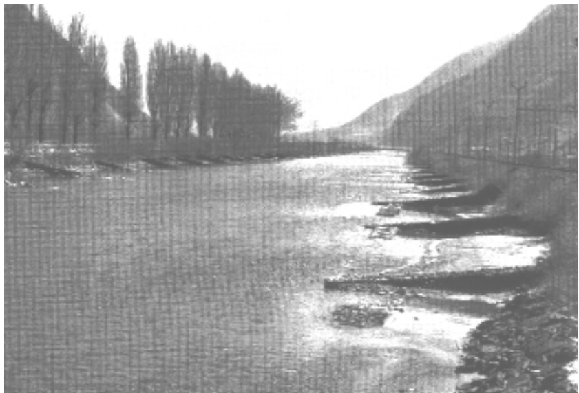
Abbildung 22. Rhonelauf zwischen Brigerbad und Lalden. Linkes Bild: Luftaufnahme am 7.4.1930 vor der zweiten Rhonekorrektion. Am unteren Bildrand die Brücke von Lalden. Rechtes Bild: Blick von dieser Brücke flussaufwärts. Zustand am 20.4.1955 nach der Korrektion der Rhone flussabwärts bei Visp. Die Kiesbänke sind komplett verschwunden. Beide Bilder aus SFRD (1964).
