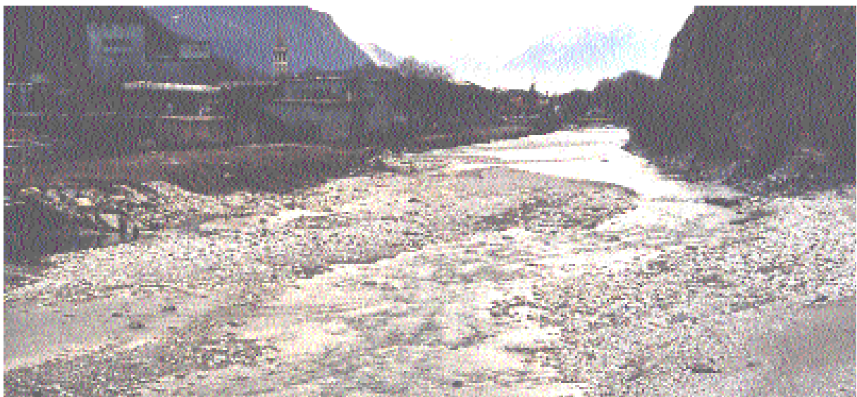
Abbildung 19. Morphologische Strukturen der Rhone auf Höhe der Aluminiumfabrik Chippis. Oberes Bild: Luftaufnahme im Sommer 1999 oder 2000 bei hohem Wasserstand. Am rechten oberen Bildrand die Fussgängerbrücke. Aufnahme "Swissimage", © Office fédéral de topographie (DV023268). Unteres Bild: Aufnahme von der Fussgängerbrücke aus flussabwärts am 7.3.2001 bei tiefem Wasserstand. Zwischen der oberen und der unteren Aufnahme liegt das Starkhochwasser vom Oktober 2000 (Kapitel 4.2).
